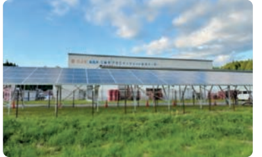
太陽光発電設備
