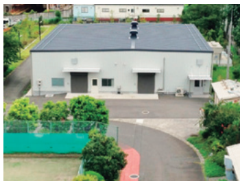
ライフケミカル事業部横浜分室 製造棟
