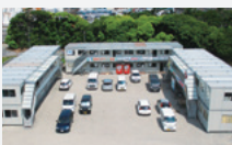
増設した作業員控所
