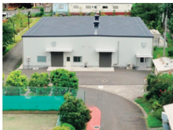
化学品事業部ライフケミカル部 横浜分室製造棟
